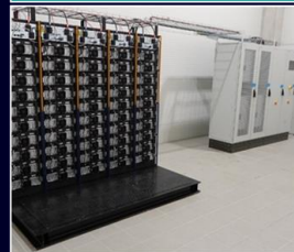
BSAE 92-552kVA se střídači KACO
